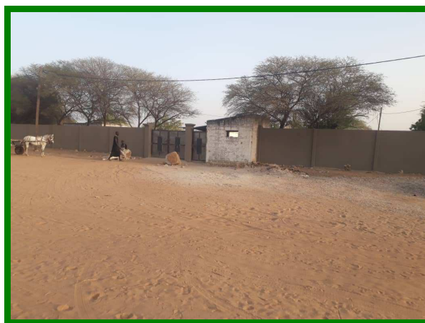
Mur du centre des métiers
