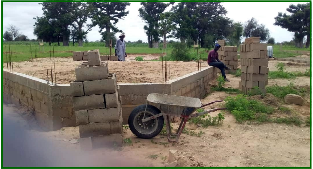
construction du bâtiment central à Darou Ndim,
